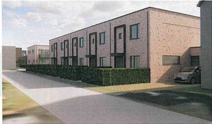
Aanzicht vanaf de Doornhoeve op de grondgebonden woningen
