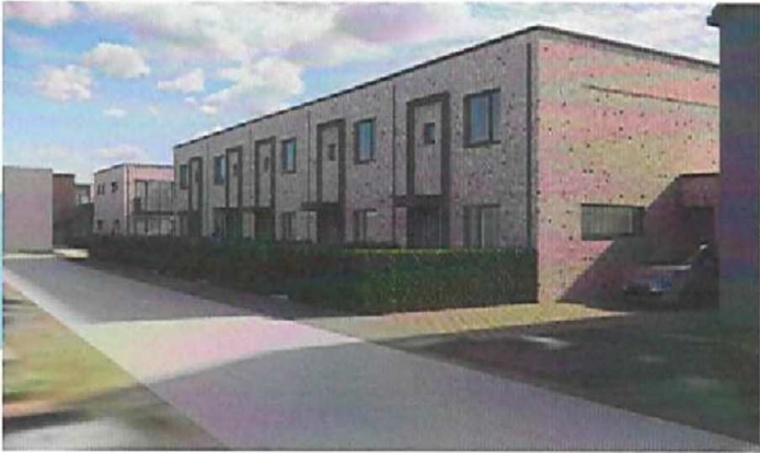
Aanzicht vanaf de Doornhoeve op de grondgebonden woningen
